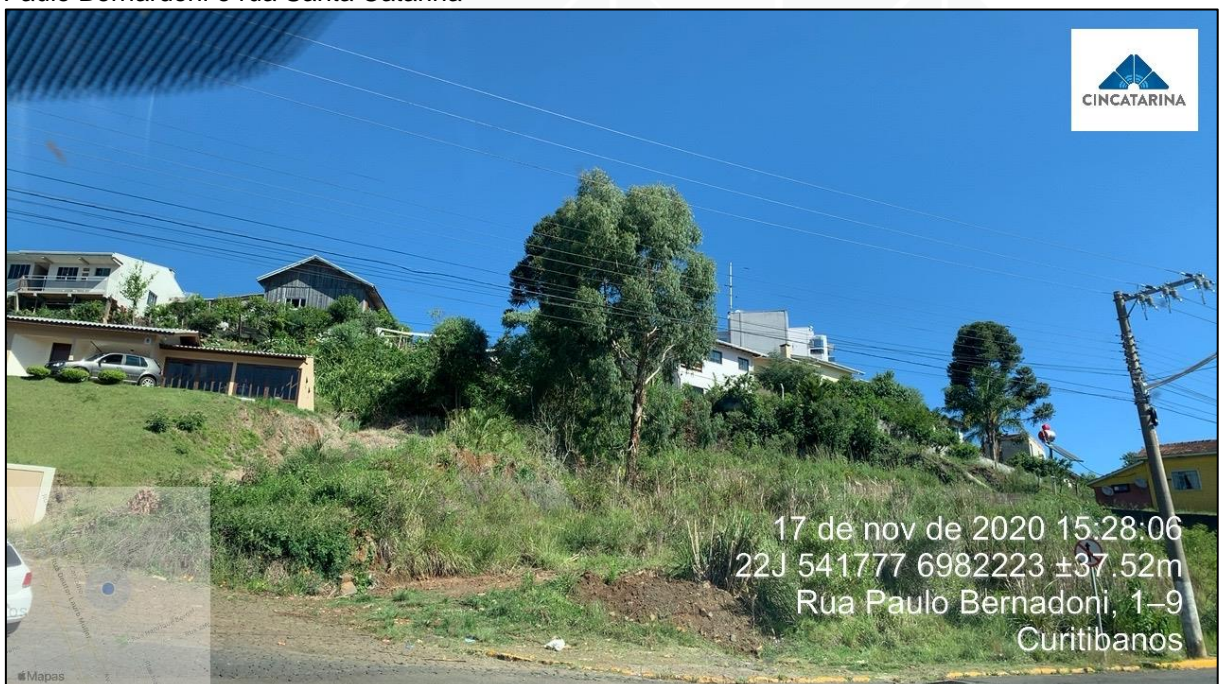
Figura 63 – Calçada sem continuidade e delimitação no entroncamento das ruas Cel. Albuquerque, rua Paulo Bernardoni e rua Santa Catarina
