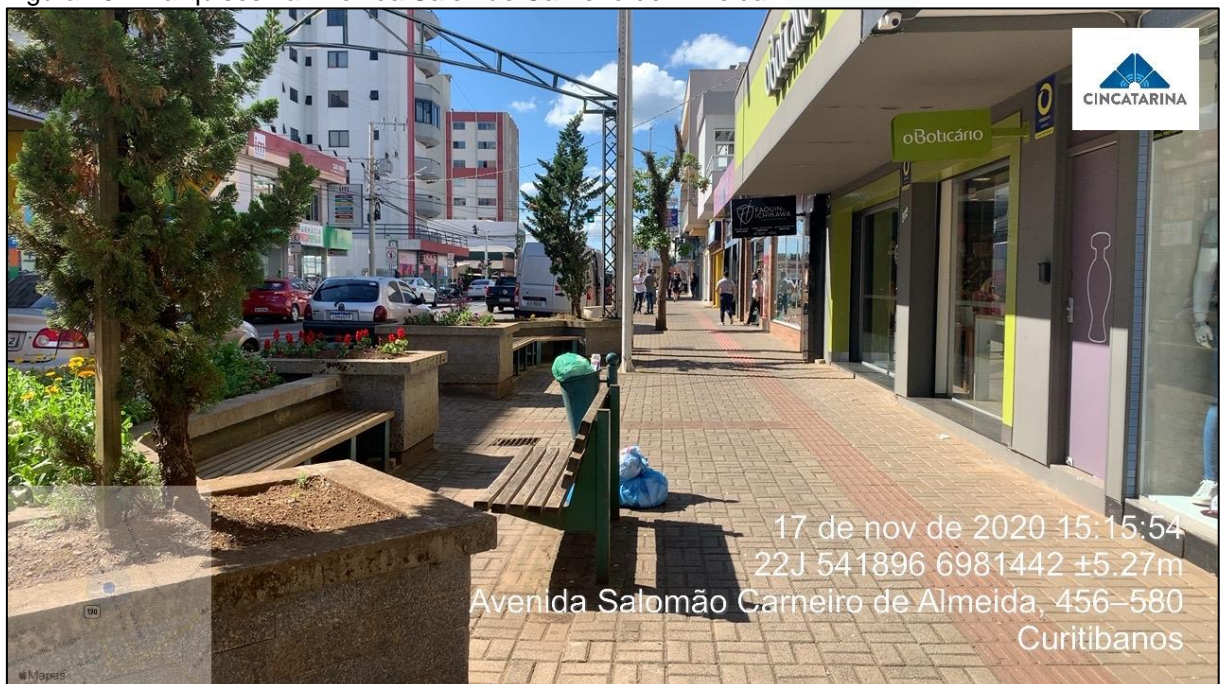
Figura 25 - Marquises na Avenida Salomão Carneiro de Almeida
