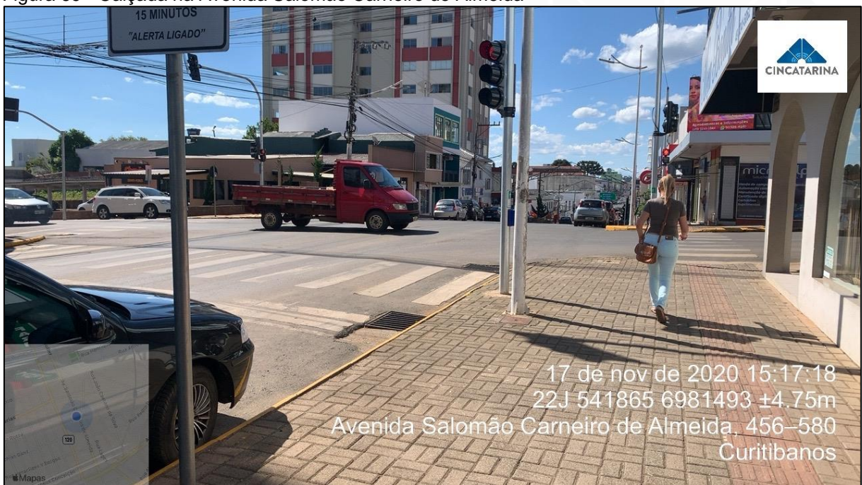
Figura 69 - Calçada na Avenida Salomão Carneiro de Almeida
