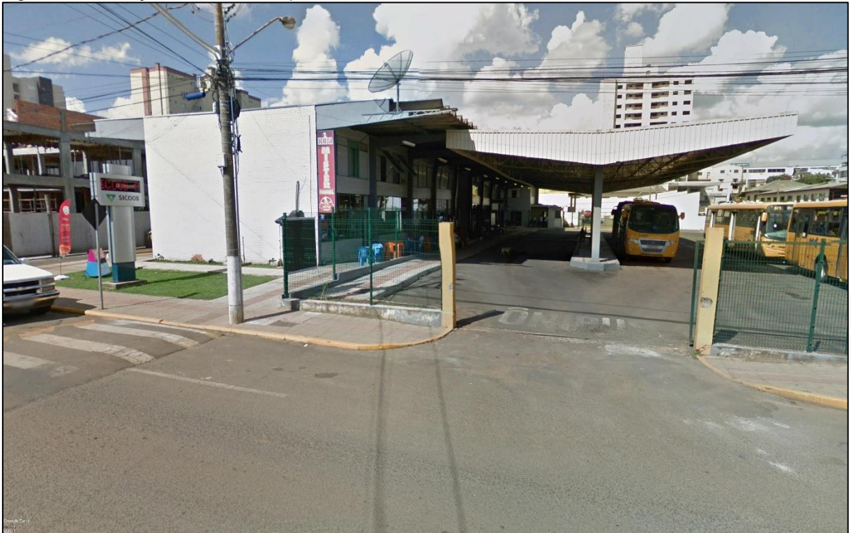
Figura 115 – Calçada e acesso de pedestres em frente ao terminal urbano
