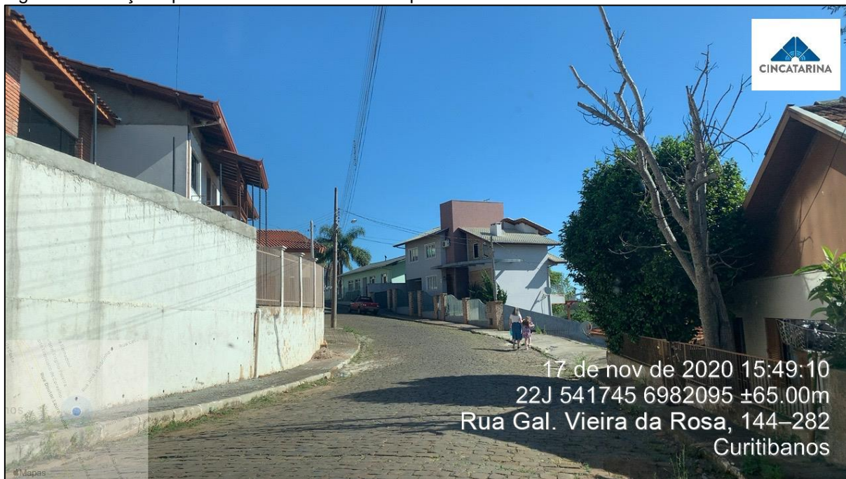
Figura 67 - Calçada pública sem dimensões adequadas na rua General Vieira da Rosa
