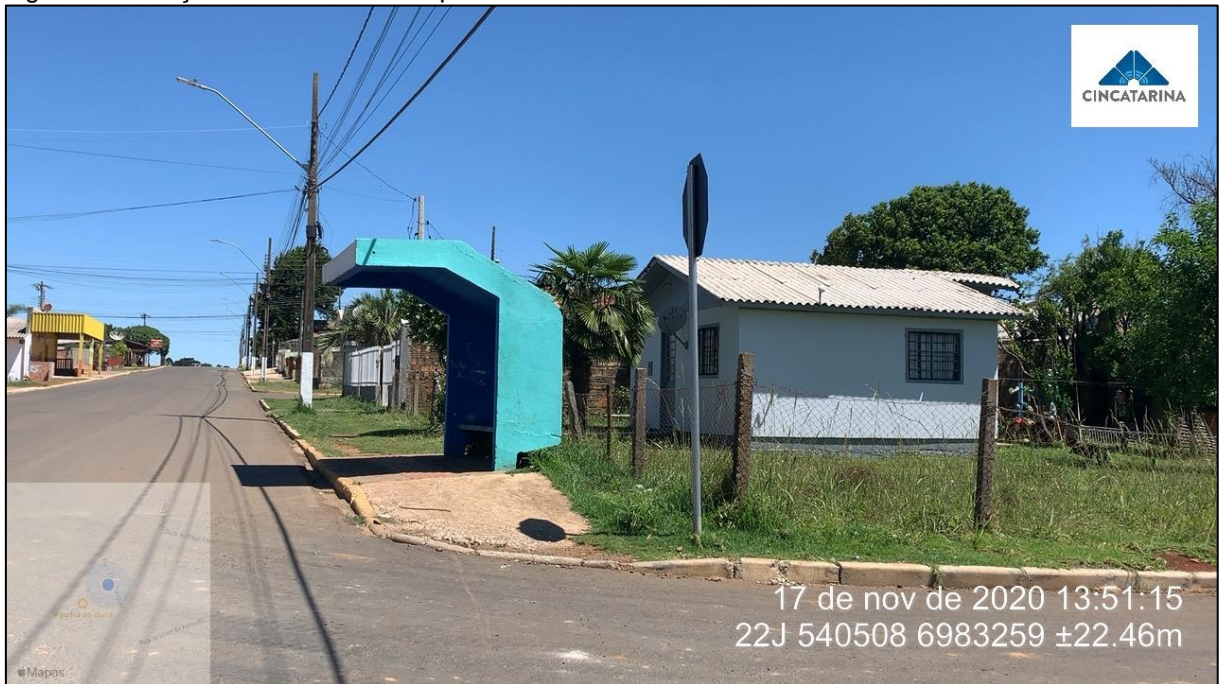
Figura 59 - Calçada na Rua Frei Gaspar
