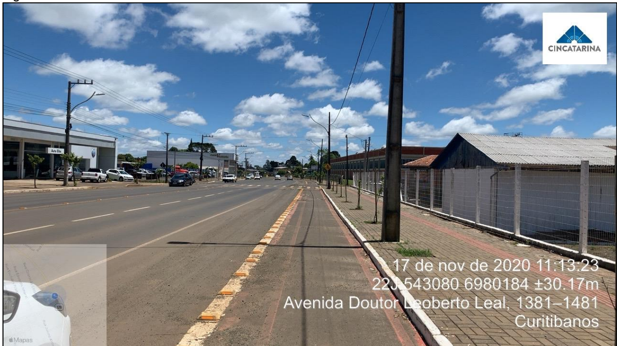
Figura 74 - Ciclovia - Avenida Doutor Leoberto Leal
